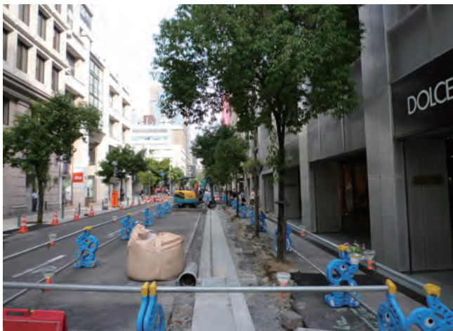
写真4 - 歩道の拡幅と根っここの処理
