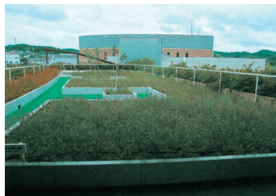
樹木による屋上緑化（三木市）
