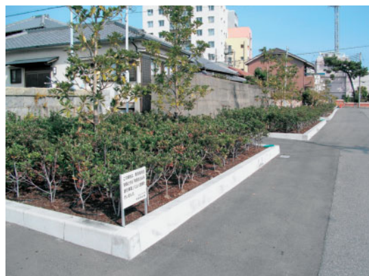
沿道の緑化（神戸市垂水区）
