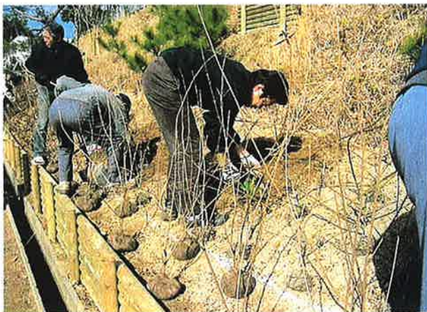
団地斜面地の緑化(川西市)
