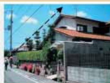
2階の外壁面を道路から後退させて上空への広がりが増しています。
